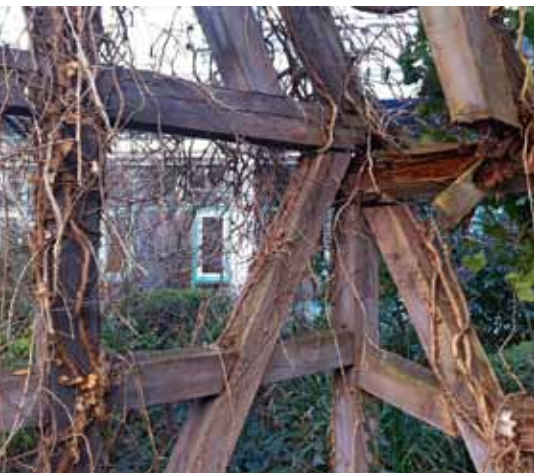
Sehr desolat präsentierte sich das Fichten-Fachwerk nach über 20 Jahren Bewitterung in Ulm
